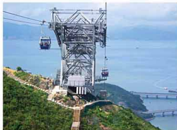
Tower Fabrication for NP360 東涌纜車塔製造工程
