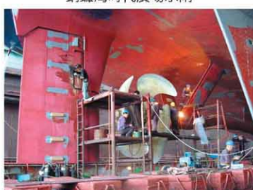
Machinery Repair 機械維修
