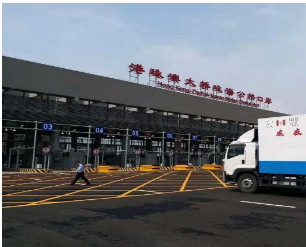
上圖：宏豐首班車次往港珠澳大橋
